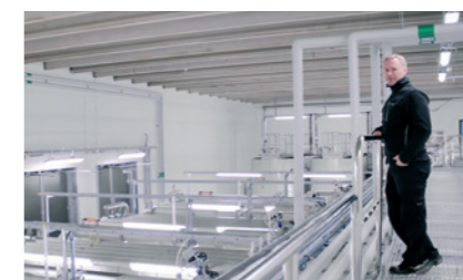
Nytt vattenverk vid Kåsjön.
