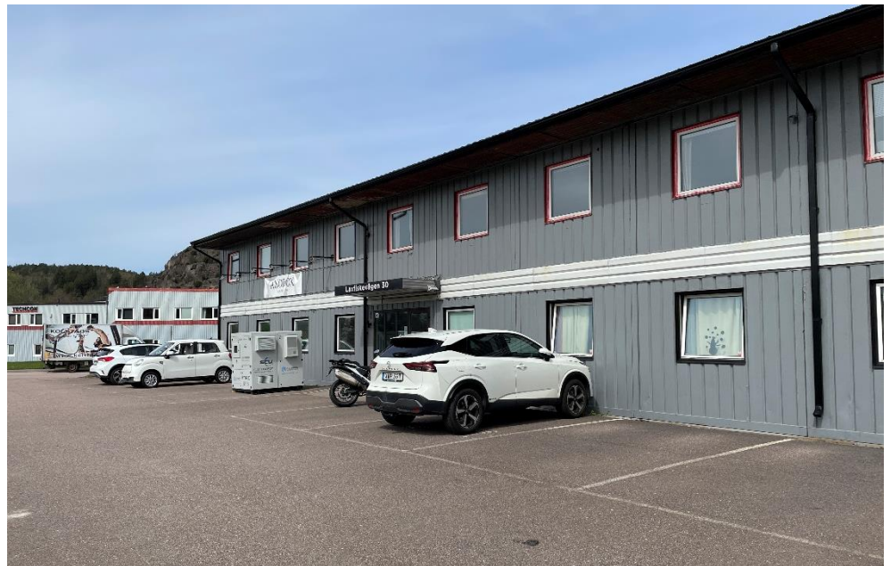
Figur 9. Exempel på utkastare till mark. Bild från platsbesök.
