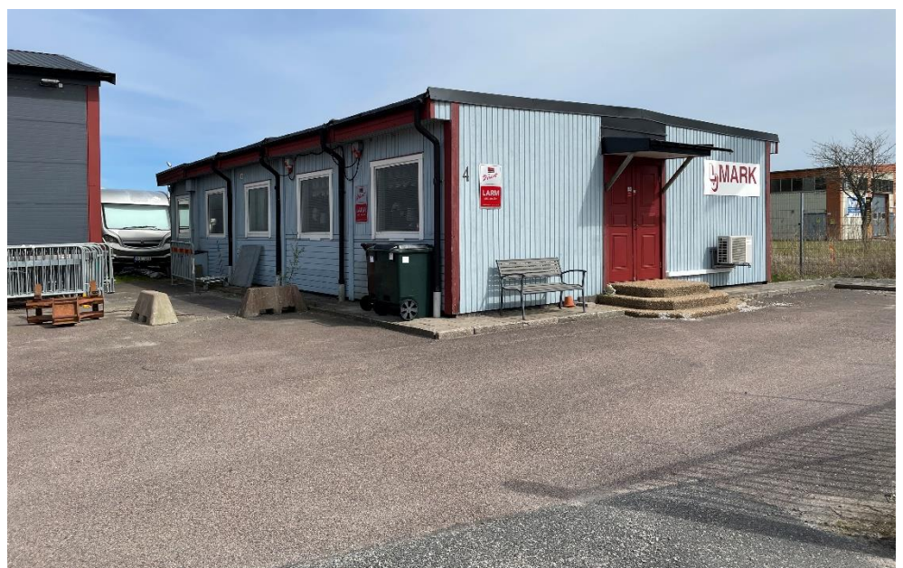
Figur 10. Enda fastigheten med stuprör med markanslutning. Bild från platsbesök.
