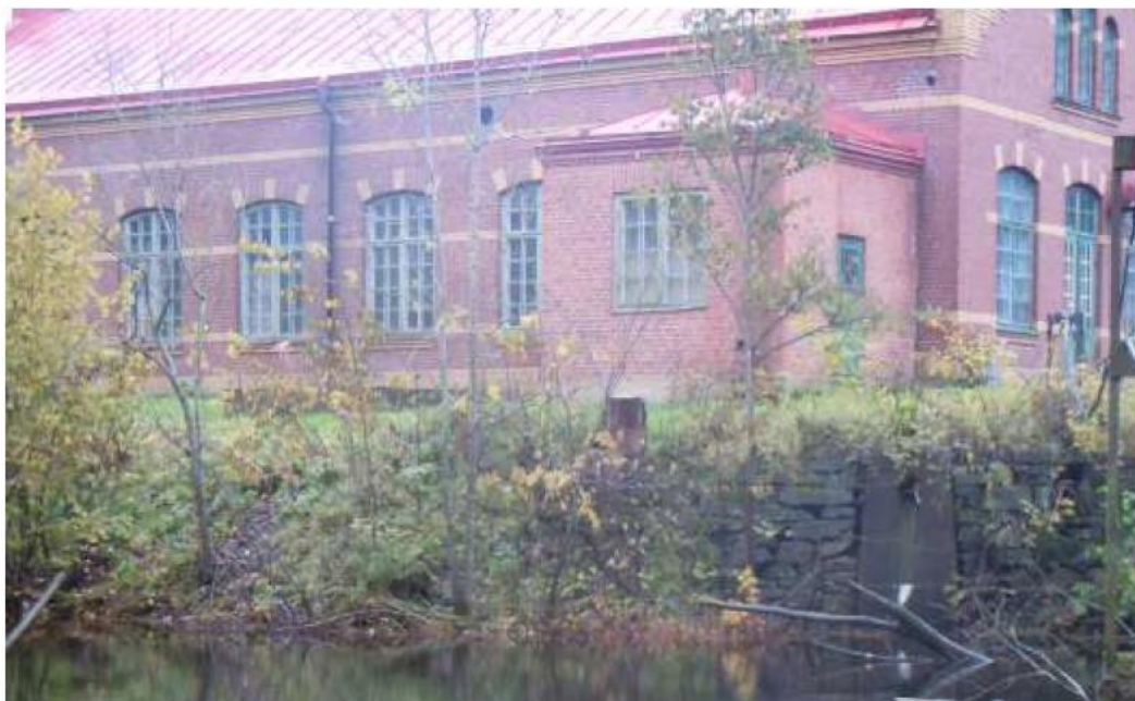
Figur 7: Slänt och stödmur med kabelupphängning mot Sävån sett från Sävåns södra strandkant. Fotoriktning: öst.
