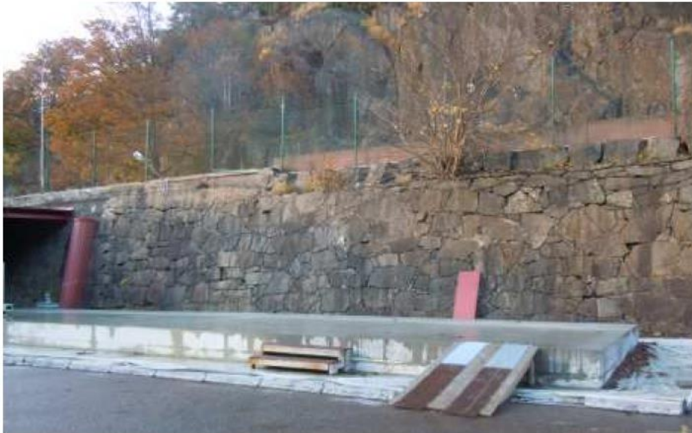
Figur 4: Stödmur mot GC-väg i planområdets nordöstra del. Fotoriktning: norr.
