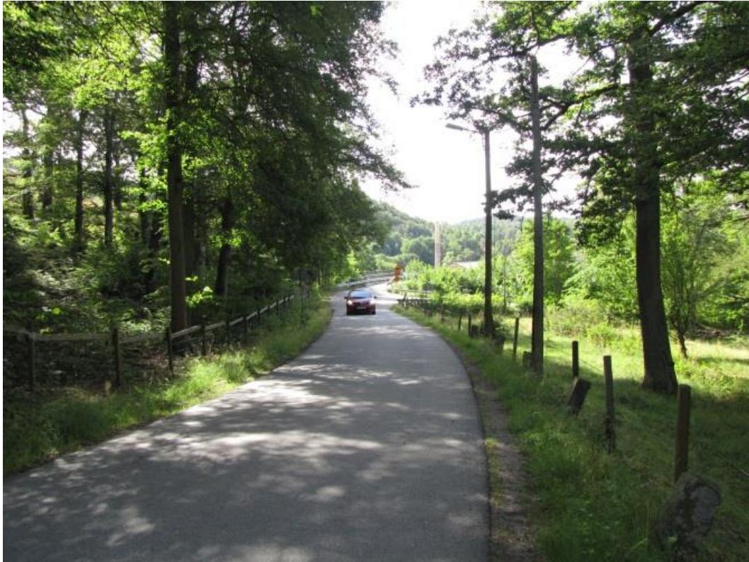
Figur 15 Granitpollare från ett äldre räcke på William Gibsons vägs västra sida.
