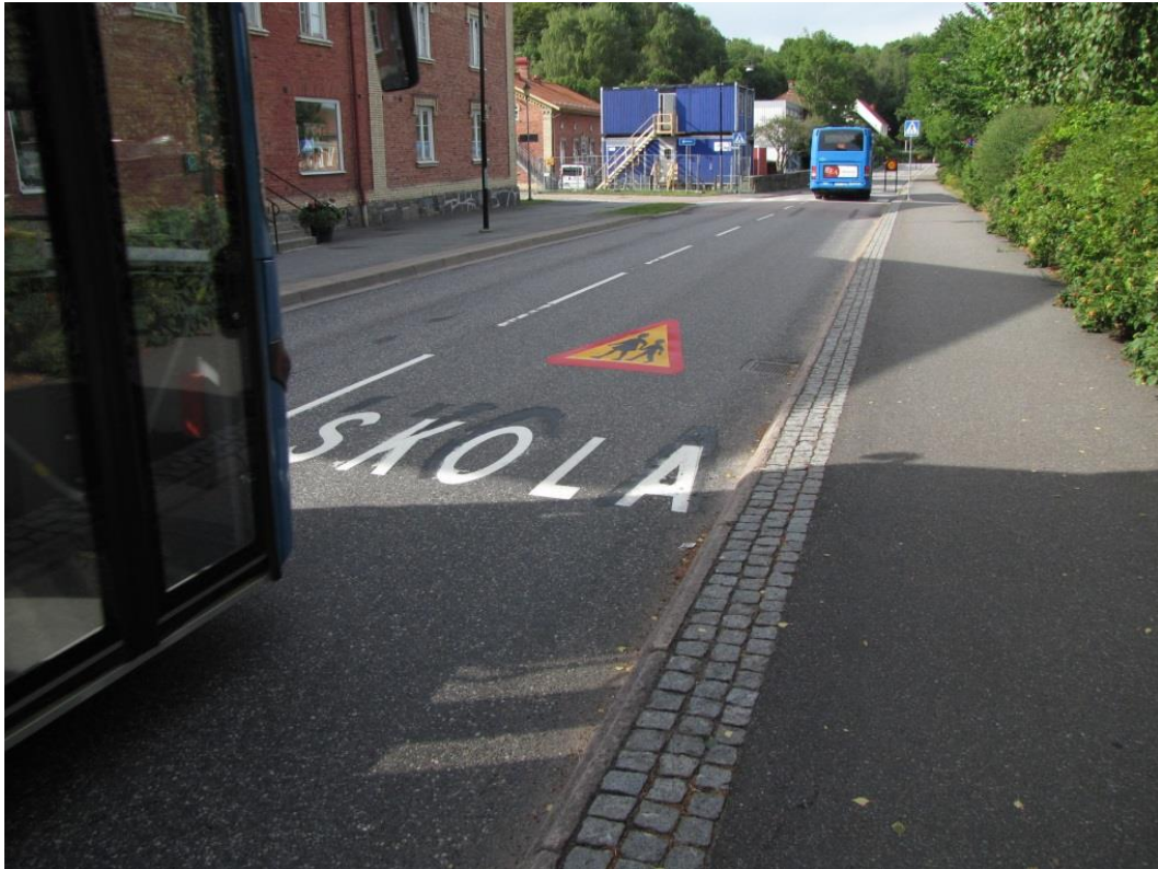
Figur 22 Varning för skola är målat på körbanan.
