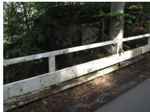
Figur 14 Stödmur längs William Gibsons väg med bristfälligt räcke.
