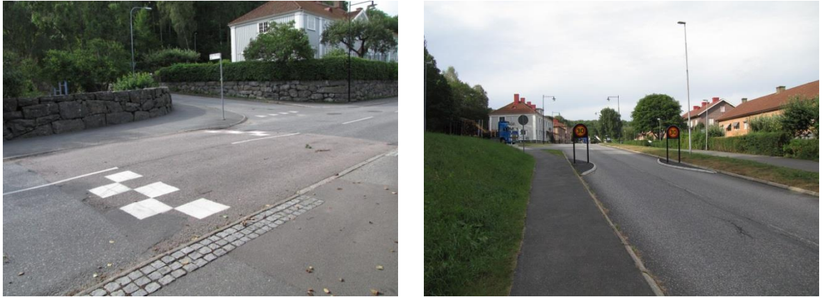
Figur 20 Hastighetsdämpande åtgärder på Jonseredsvägen.
