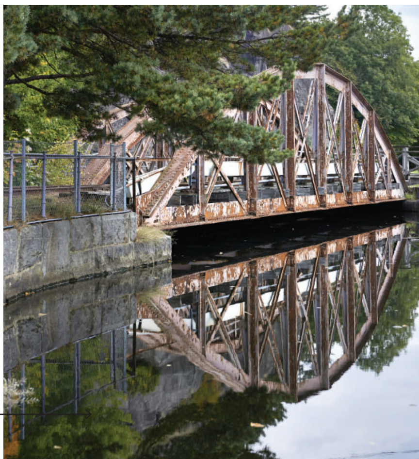
Bild på gamla järnvägsbron vid Jonsered's fabriker.
