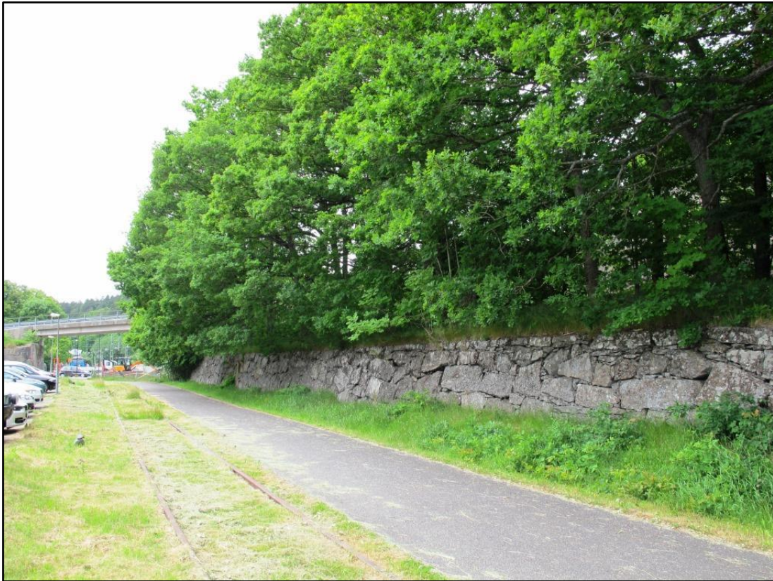
Bild 13. Större lövträd på den uppbyggda banvallen.
