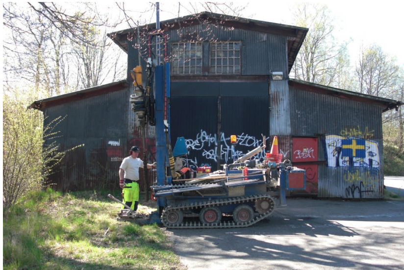
Figur 3. Provtagning vid BH4.
