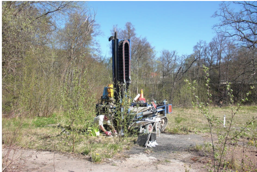
Figur 2. Provtagning vid BH1.
