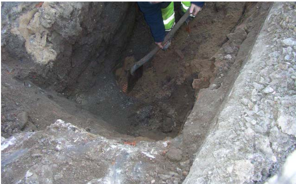
Figur 3. Försiktig handschaktning runt avloppsledning vid grävning av provgrop (pp39),
