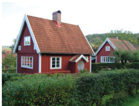
Bebyggelse i trä som ligger i närheten av fabriksområdet i Jonsered.
