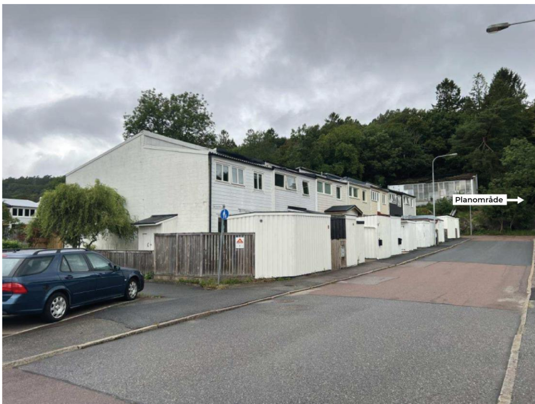
Figur 6. Radhus längs med Smedjegårdsvägen. Flacka sadeltak med asymmetriska fall. Fasader i liggande panel. Gavelsidor i vitmålade lättbetongblock.
