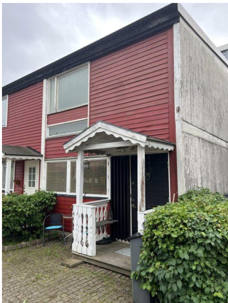
Figur 7. Radhus inom Vintergäcken. Flacka sadeltak med asymmetriska fall. Fasadmaterial i rödfärgad fjällpanel och gavelsidor i vitmålad betong.
