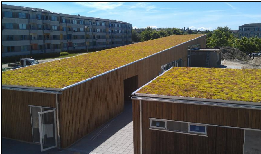
Figur 19. Exempel på sedumtak (Källa: Engman Tak AB)
