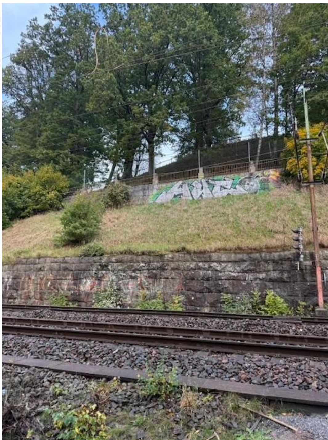
Figur 7: Befintlig stenmur vid järnvägsspår.
