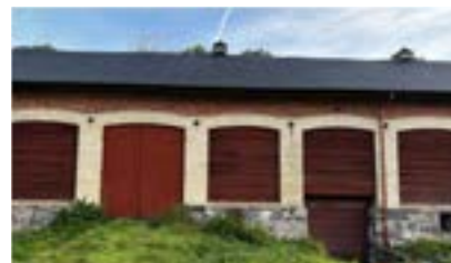
Ladugården med fasader i rött och gult mönstermurat tegel. I fasaderna syns även ankarslut av gjutjärn (foto från Kulturmiljöunderlag, Acanthus).
