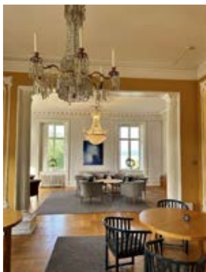
Salongen på första våningen med ekgolv, rikt profilerade listverk, stuckaturer på väggfält och i tak, äldre takkrona samt kolonner (foto från Kulturmiljöunderlag, Acanthus).
