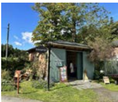
Rosengaraget, östra fasaden med skjutdörrar (foto från Kulturmiljöunderlag, Acanthus).
