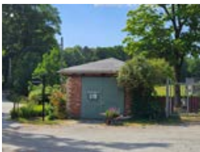
Rosengaraget östra fasad.
