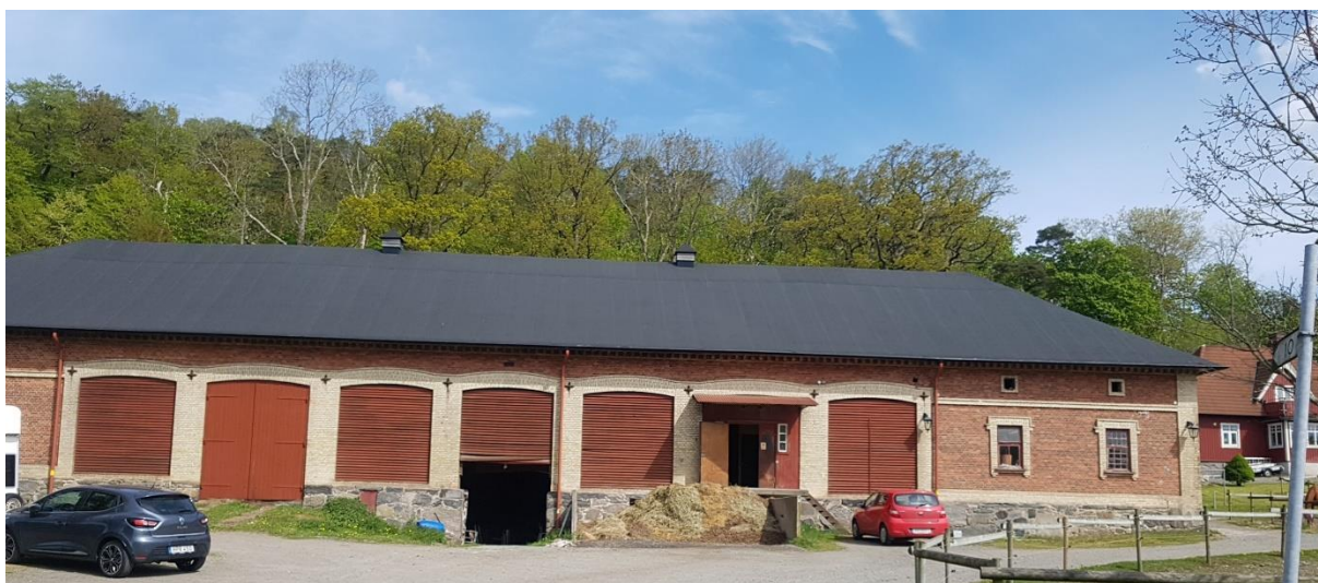
Figur 5-13. Del av fasaden till ladugården med karakteristisk tegelarkitektur i mönstermurat rött och gult tegel.
