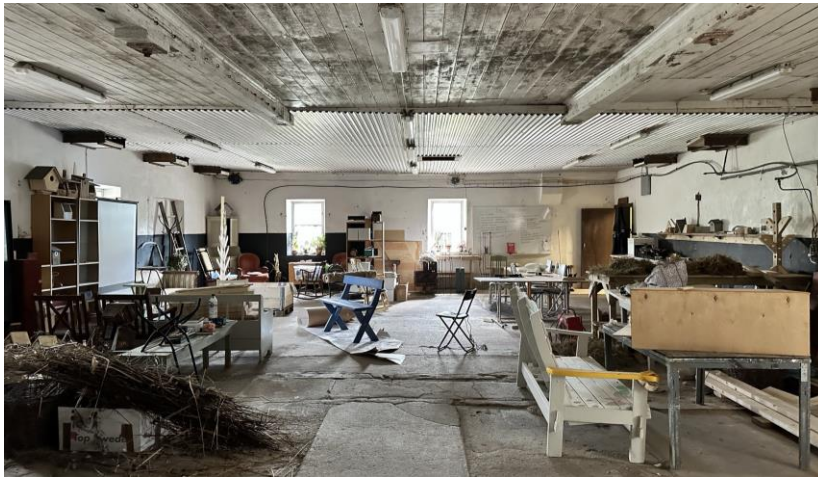
Bild på ladugårdens östra del interiört med ett större rum som tidigare var ett stall för hästar, med gjutet betonggolv, putsade väggar, spröjsade fönster i djupa fönsternischer samt träpanel i taket. Taket har på senare tid kompletterats med korrugerad plåt. Rummet i gult visar nuvarande entrén.
