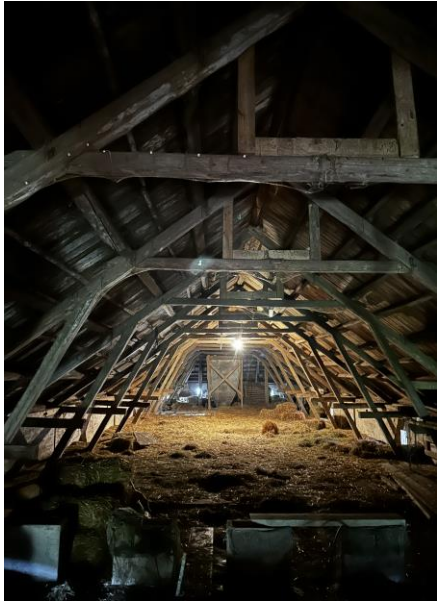
Takstolarna av trä uppe på loftet.
