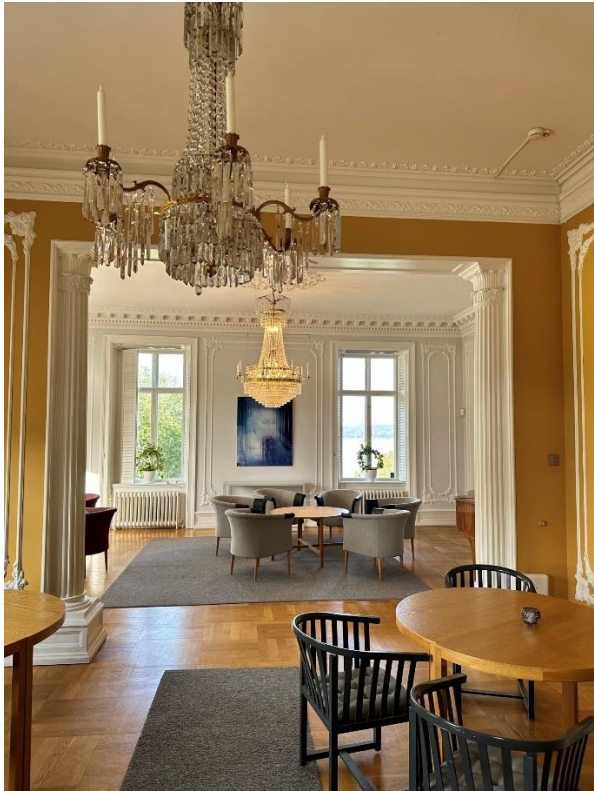
Salongen på första våningen med ekgolv, rikt profilerade listverk, stuckaturer på väggfält och i tak, äldre takkrona samt kolonner. Detalj t.h. visar dekorerad fältindelning på vägg av stuck.
