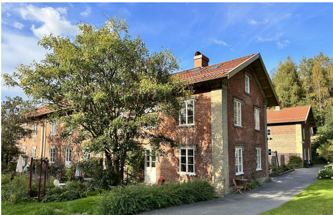
F.d. arbetarlänga i Jonsereds samhälle med tegelarkitektur i rött och gult handslaget tegel med friser och dekor, utkragande takfot klädd med träpanel och snidade taktassar, fönster och dörrar av trä samt tegeltak. Utformningen anknyter till ladugården och grindstugan vid herrgården.
