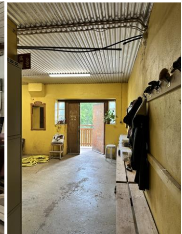
Bild på ladugårdens östra del interiört med ett större rum som tidigare var ett stall för hästar, med gjutet betonggolv, putsade väggar, spröjsade fönster i djupa fönsternischer samt träpanel i taket. Taket har på senare tid kompletterats med korrugerad plåt. Rummet i gult visar nuvarande entrén.
