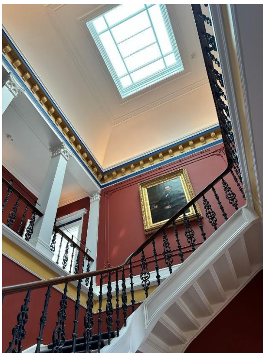
Trapphuset med gjutjärnsräcken, pelare, taklister, stuckatur och spröjsad taklanternin
