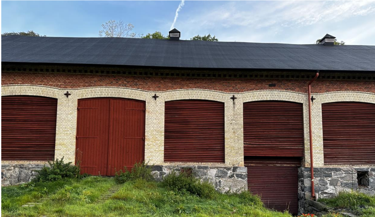
Ladugården med fasader i rött och gult mönstermurat tegel. En svagt böljande tegellist löper mellan tegelpartierna. I fasaderna syns även dekorativa ankarlut av gjutjärn. Framför den stora pardörren syns en upphöjning i mark belagd med natursten. Till utrymmet i källaren leder stenlagda sidopartier samt en gång. Båda är viktiga egenskaper för att få förståelse och kunna avläsa hur byggnaden har använts.
