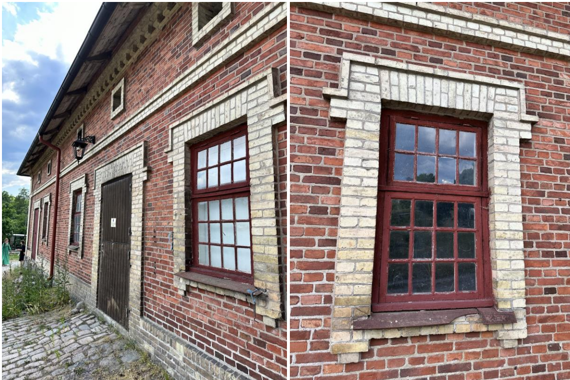
Ladugården mot öster med tegelfasader med mönsterlagt tegel i flera olika nyanser. T.h. ett ursprungligt småspröjsat 2-luftsfönster med solbänk (fönsterbleck) av gjutjärn.
