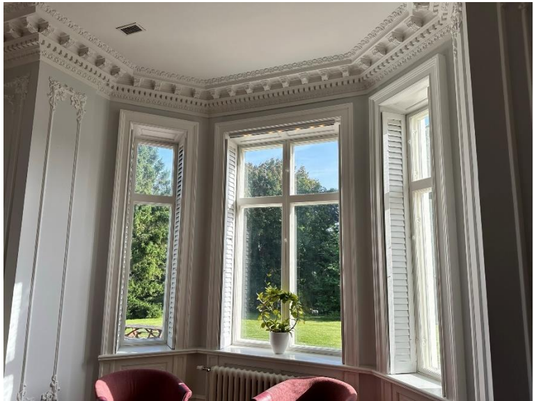
T.h. burspråk med ursprungliga korpostfönster med fönsterluckor av trä med jalusipanel och rikt utsmyckade väggar och tak med friser.
