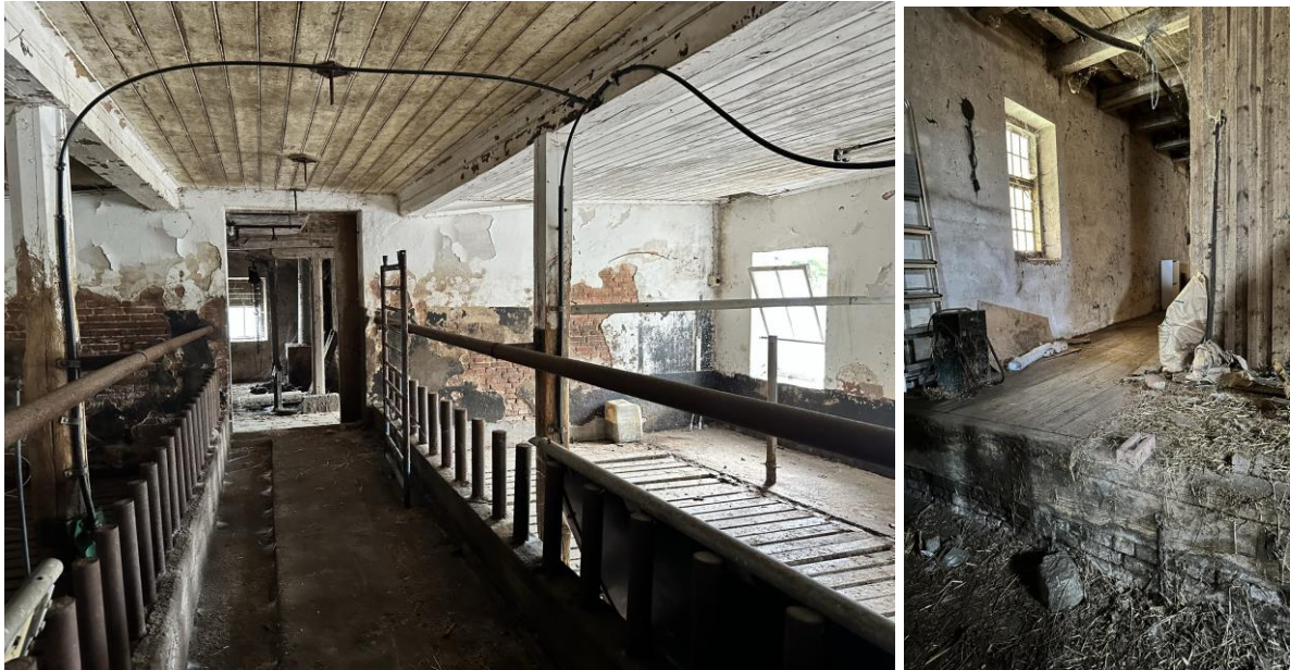
I de västra delarna av ladugården finns ett stall med djurbås. Här syns en äldre träkonstruktion med takbalkar och pelare av trä med avfasade kanter samt inklätt tak med pärlspontspanel. Anslutande rum har bjälklag i olika nivåer. Material som förekommer är både trä, tegel och vitkalkad puts.
