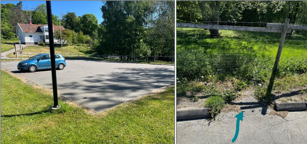
Figur 18. Parkering i områdets östra delar med släpp i kantstenen. (Foto: Norconsult)
