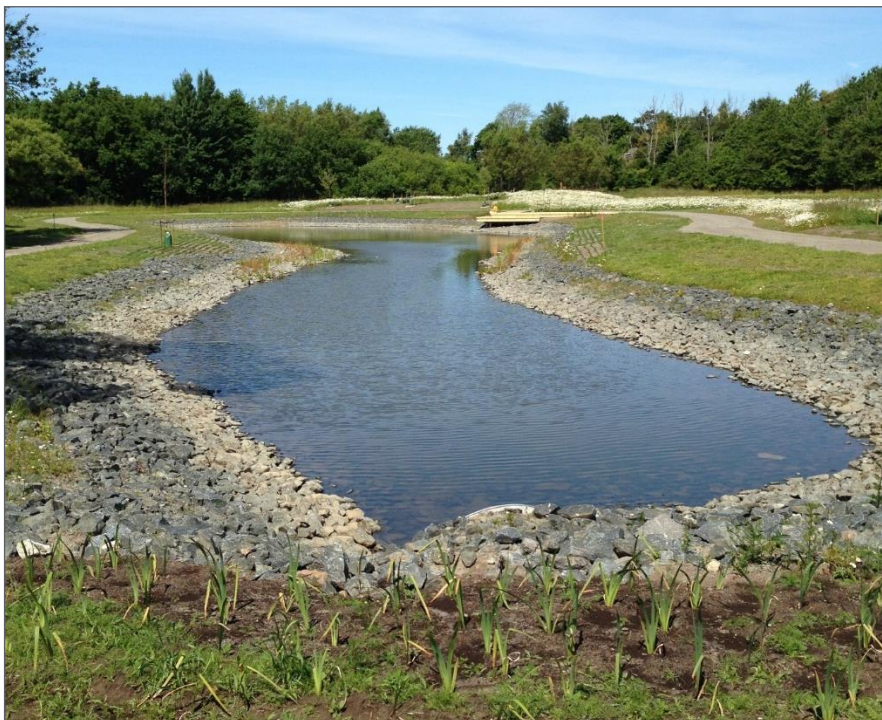
Figur 20. Exempel på dagvattendamm i Trönninge, Varberg. (Foto: Norconsult)
