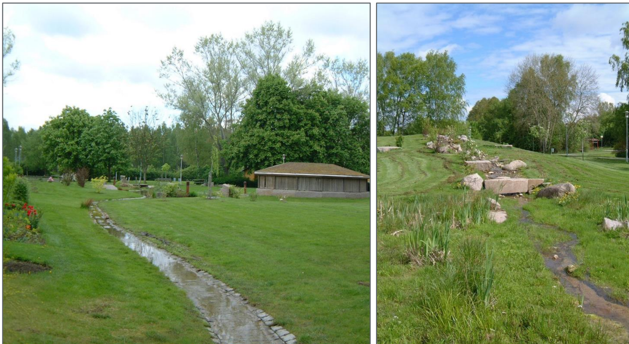
Figur 24. Exempel på utformning av dike (Foto: Norconsult).
