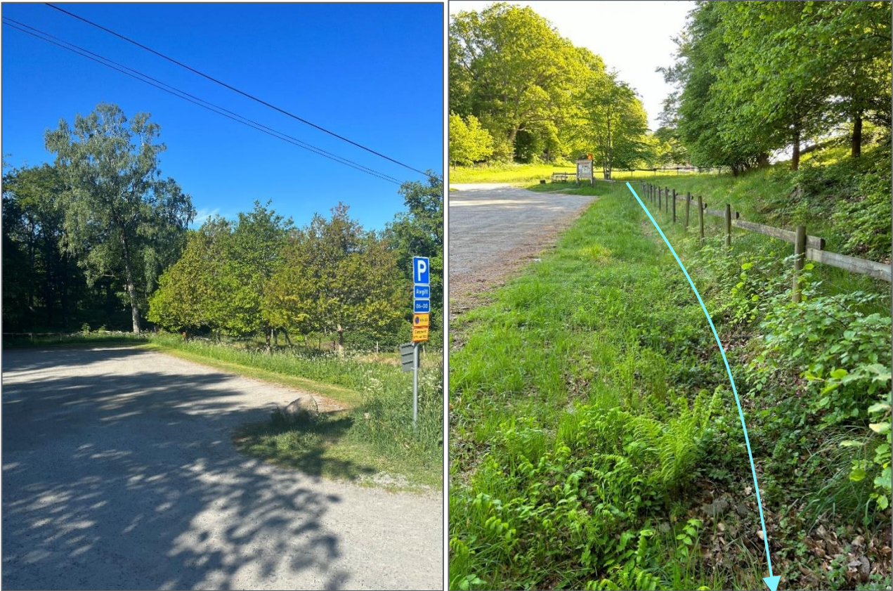
Figur 15. Grusparkering längs William Gibsons väg och dikesliknande lösning i parkeringens kant. (Foto: Norconsult)
