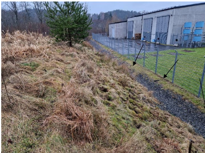
Bild 14. Bild från befintliga diket från en annan vinkel. Till diket ansluts flera dräneringsledningar från grannfastigheten/befintlig transformatorstation.
