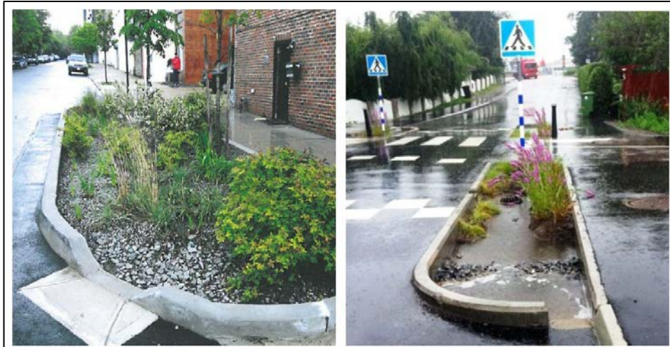
Figur 21. Exempel på biofilteranläggning. Till vänster: Det är viktigt att inloppet placeras på korrekt höjd för att avrinningen från ytorna ska kunna ledas in i anläggningen på ett smidigt sätt. Bildkälla: Regnbädd i New York City (DEZENTRALE REGENWASSERBEWIRTSCHAFTUNG Ausarbeitung im Projekt Stadtbäume im Klimawandel (SIK) gefördert vom BMUB, 2018). Till höger: Översvämmad anläggning: Det är viktigt att vid inloppet anlägga erosionsskydd, till exempel ett lager makadam, för att förhindra att filtermaterialet sköljs bort vid höga flöden. Bildkälla: Öringevägen, Tyresö.
