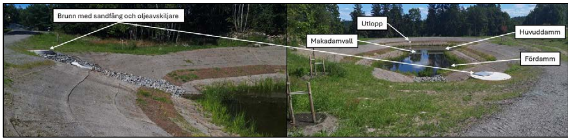
Figur 24. Exempel på utformning av en våtdamm med för- och huvuddamm uppdelad med hjälp av makadamvall. ©COWI
