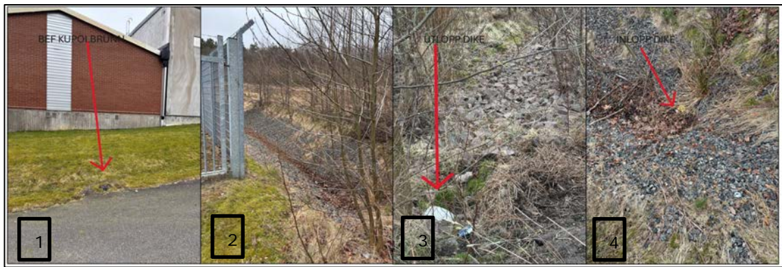
Figur 5. Från vänster: 1-Den befintliga kupolbrunnen väster om stationsbyggnaden. 2-Det befintliga diket söder om stationsbyggnaden. 3-Utlopp från diket mot Kåbäcken. 4-Samma utlopp, i diket. Bildkälla: Partille kommun.
