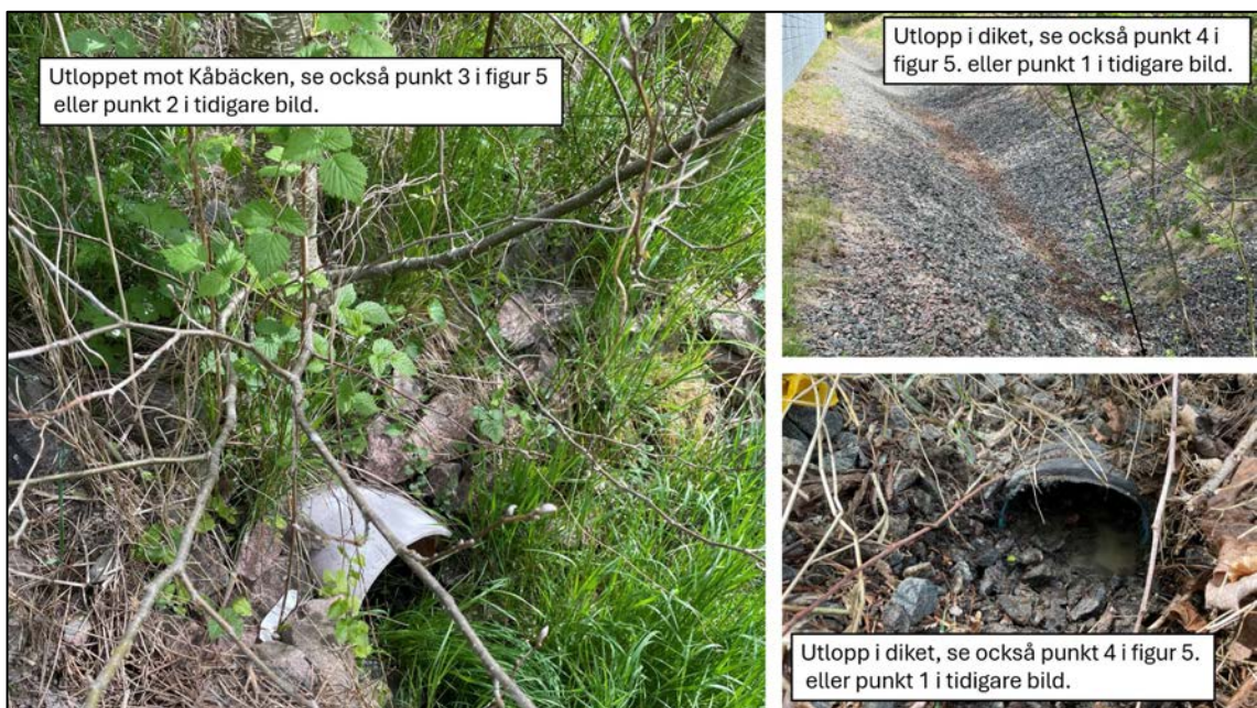
Figur 8. Bild till vänster är ett plaströr som troligen är krossdikets utlopp mot Kåbäcken. Bilderna till höger är inloppet från diket. Bildkälla: COWI.
