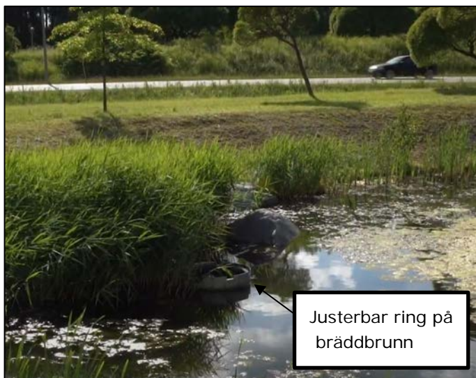
Figur 26. Exempel på bräddbrunn med justerbar kant som kan höjas eller sänkas vid behov. Bildkälla: (Jakobs, u.d.).
