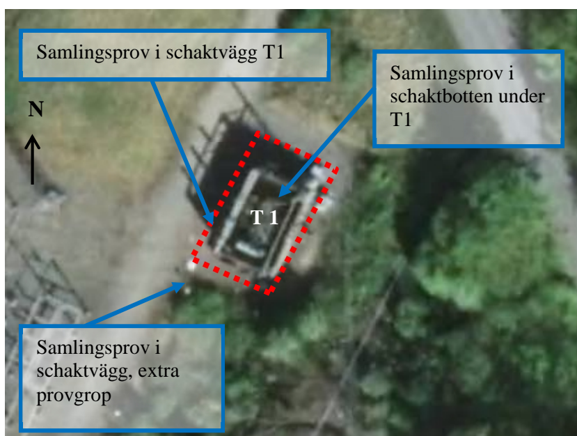
Figur 2. Figuren visar plats för uttagna kontrollprover i schaktvägg och schaktbotten kring f d transformator T1.
