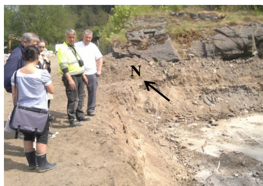
Figur 4. Tillsynsbesök den 11 maj 2011. Efter besöket tog prov i schaktvägg (V) och kompletteringsschakt utfördes.
