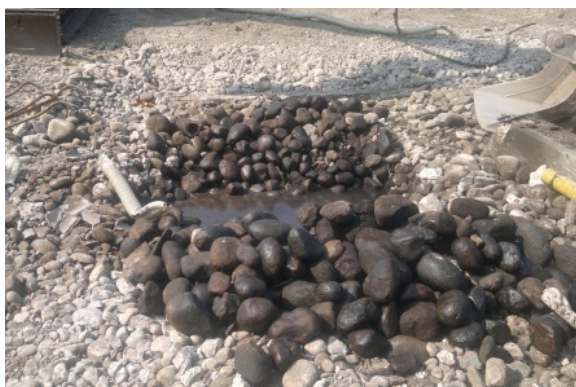
Figur 7. Oljeförorenade stenar (släcklager) i oljefånggrop vid T1.
