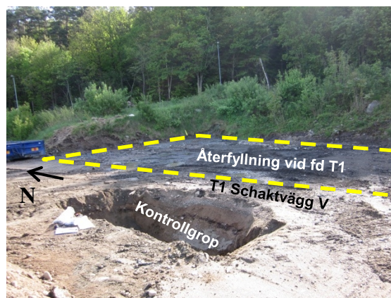
Figur 6. Provgrop (T1) nedströms (väster) ”schaktvägg V”.
