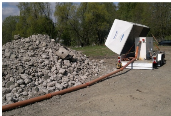
Figur 8. Mobil vattenreningsanläggning (oljeavskiljare) samt utsorterad ren betong.
