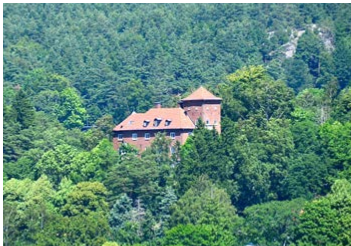
Villa Porthällas sydvästra fasad.
