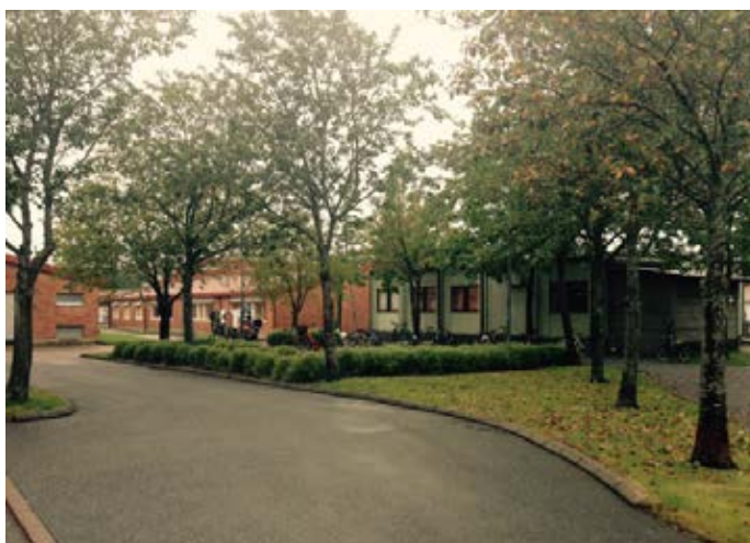
Befintlig infart från öster, cykelparkering och bortom den låg- och mellanstadieskola.
