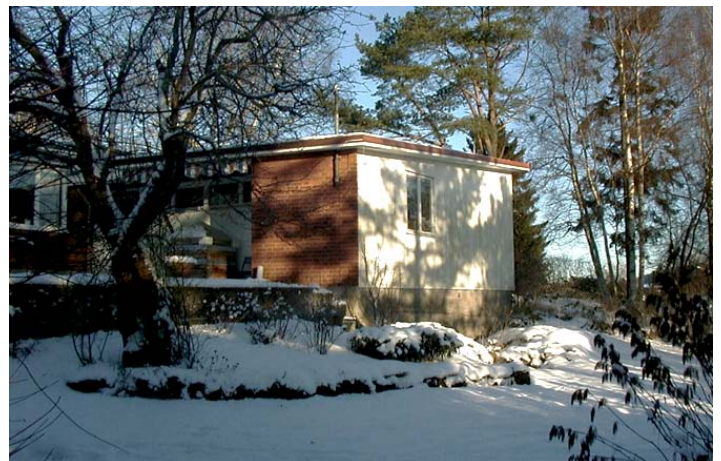
Gaveln på det vidbyggda garaget där tillbyggnad är tänkt placeras.
