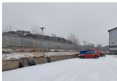
Bild 6 visar uppford skyddsvall mot Västra stambanan med skydds- och bullerplank.
