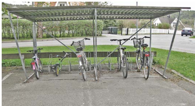
Befintlig cykelparkering placerad vid infarten till parkeringen.
