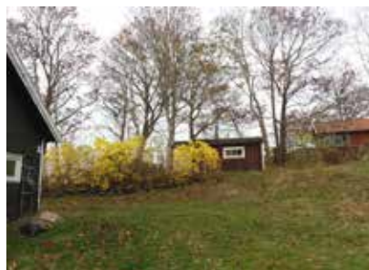
Befintlig komplementbyggnad i norr, fasad mot söder
