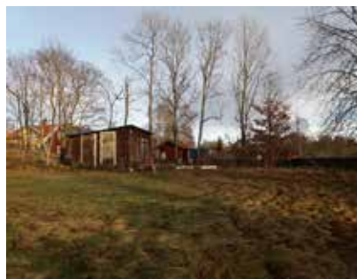
Befintlig komplementbyggnad i öst, fasad mot väster
