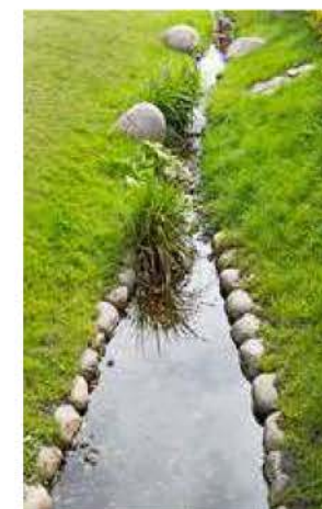
Öppet dagvattendike i Augustenborg, Malmö. Foto: mkb.se
