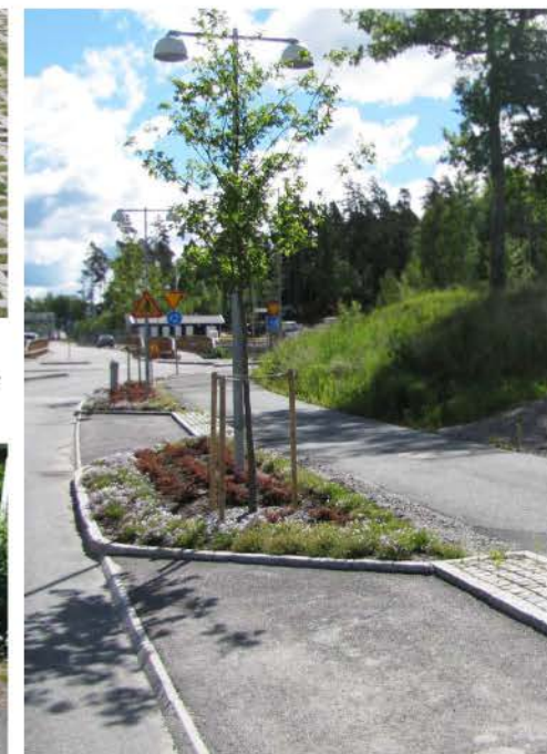
Bilden t.v. visar exempel på trottoar i samma nivå som vägbanan, avskiljd av smågatsten. Bilden ovan visar hur Bygatans gatuparkering kan utformas.
