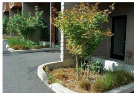
S.k. raingarden som fördröjer dagvatten, Dagvattenutredning Gökegård 2016 Sigma civil. Foto: City of Portland
