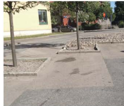
Exempel snedparkeringar till parkeringsgatan, Nya varvet. Beläggningen på parkeringsplatserna skiljer sig ifrån gatans beläggning.
