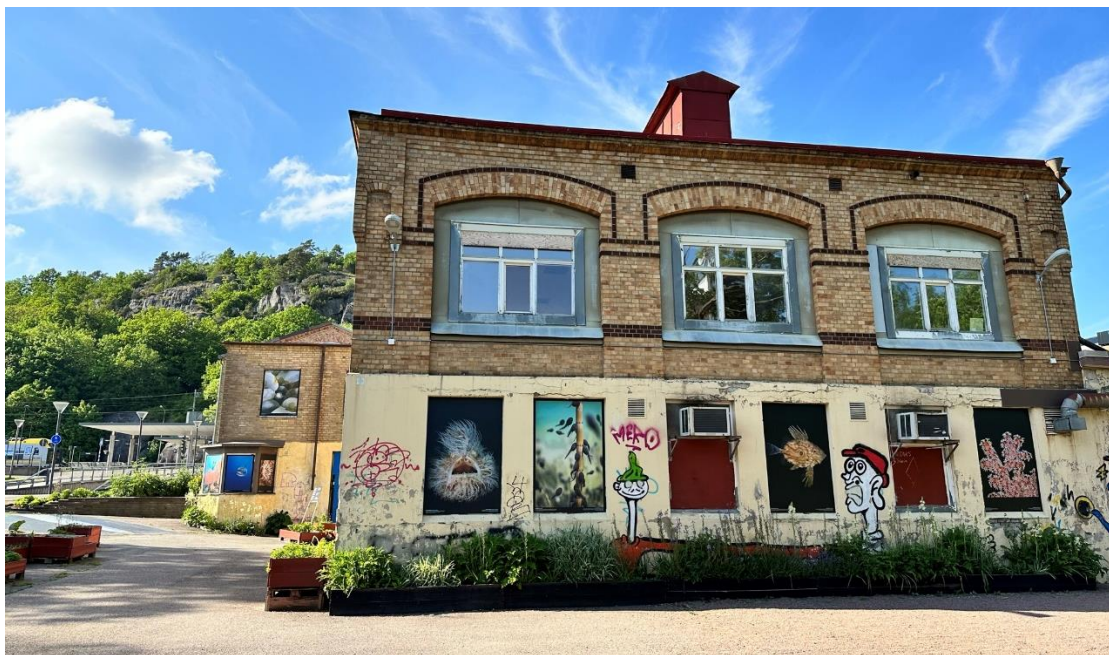
Figur 28. De äldre fabriksbyggnadernas arkitektur präglas av det dekorativt gulbruna, handslagna, hårdbrända förbländerteglet.
