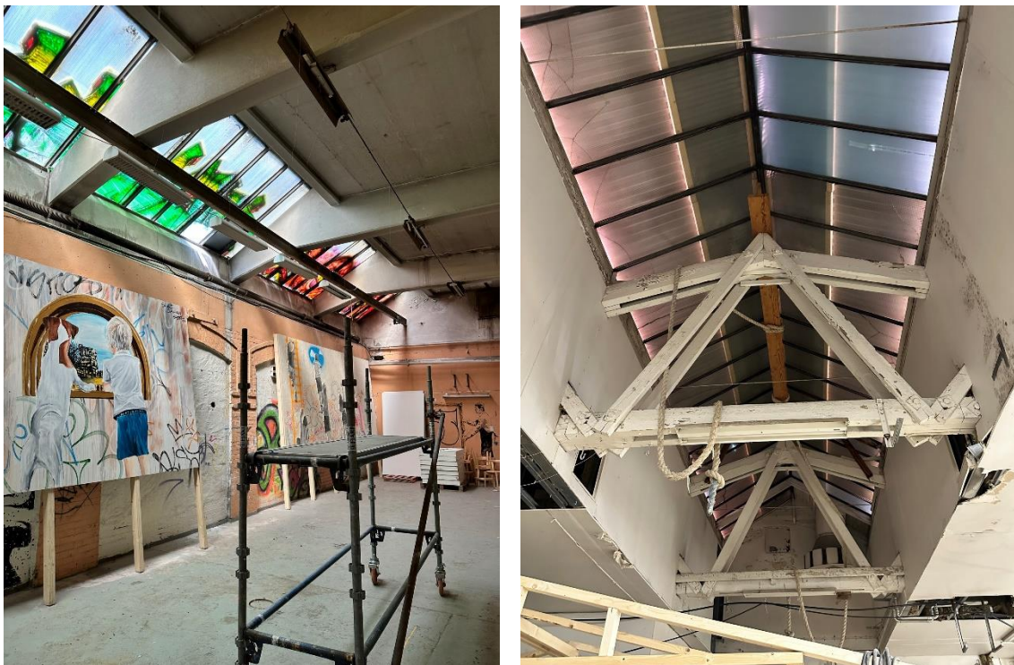
Figur 25. Takfönster, taklanterniner med tillhörande takstolar finns bevarade och synliga i fastigheten. Utvändigt har de täckts med plåt.
