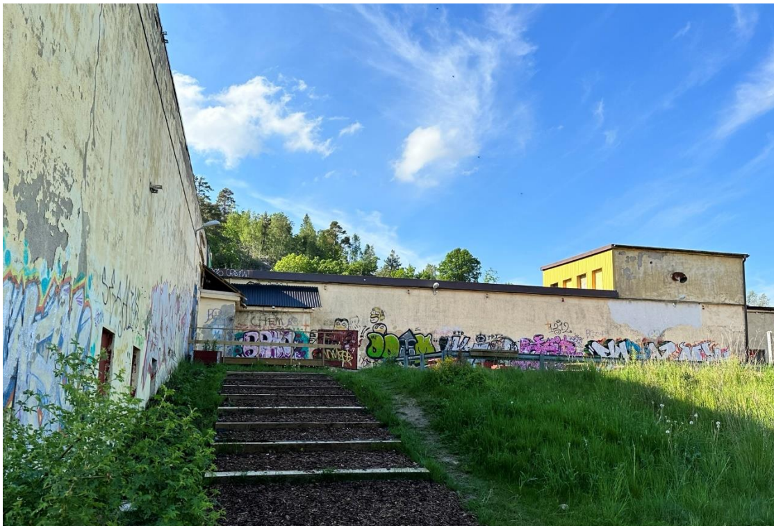
Figur 33. Kvarterets sydöstra del präglas i sin helhet av de slutna, slät- och spritputsade fasaderna. Här har tidigare funnits fler byggnadskroppar som rivits.
