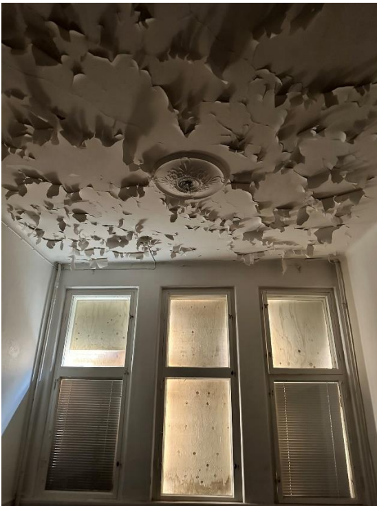
Figur 27. Takrosett, fönsterbågar från ombyggnaden 1925 finns bevarat i kontorsbyggnaden. Industriglas förekommer också som ett tidstypiskt inslag i interiören.
