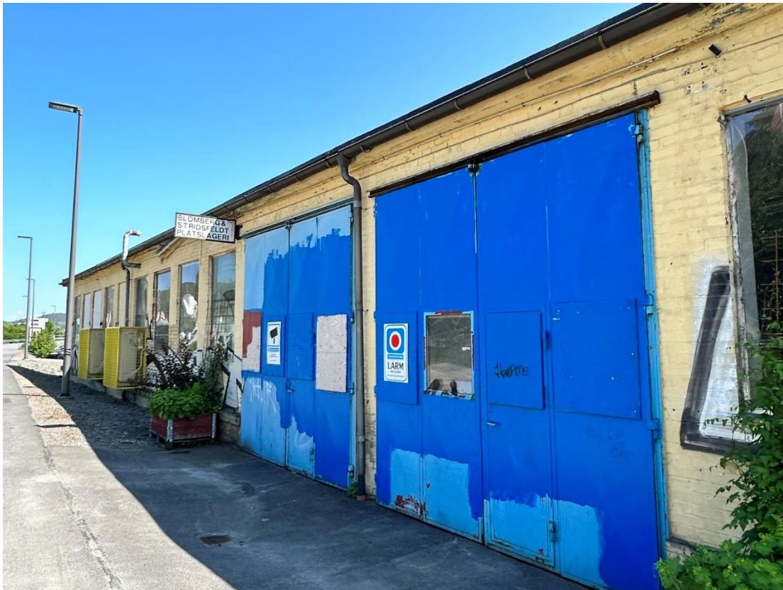
Figur 31. Stora garageportar har tagits upp på den norra fasaden under senare år. Dessa portar ger den funktionalistiska fasaden ett uppbrutet uttryck.
