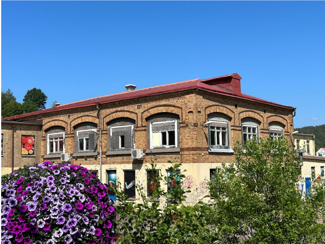
Figur 29. Kvarters sydvästra gavel, bär tydliga spår från fabriken ursprungliga byggnader. De stickbågade, småspröjsade fönstren är ersatta av moderna fönster i annan storlek.
