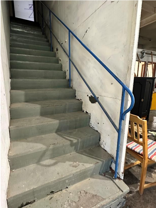
Figur 26. Trappräcken av järn, samt fönsterbågar från 1940-talet finns på ett flera ställen i byggnaderna.
