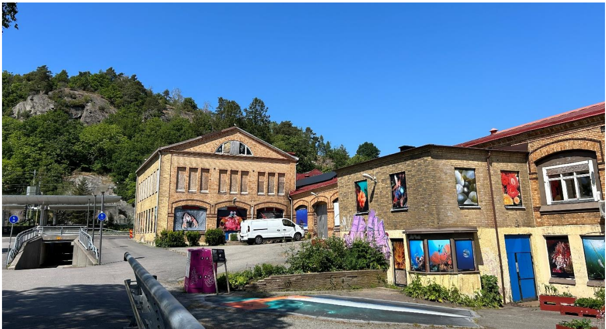
Figur 5. Kvarterets bebyggelse sett från sydväst. Här syns till stora delar kvarterets äldre bebyggelse.
