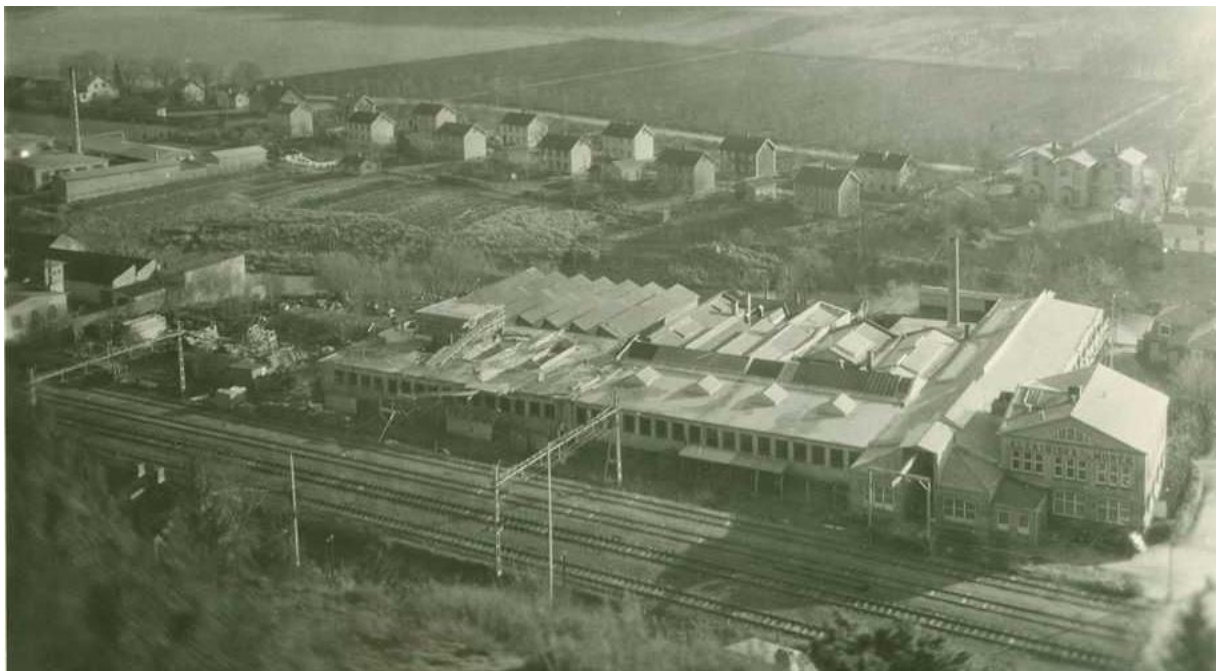
Figur 12. Utbyggnaden av fabrikslokaler i norra delen av kvarteret, längs järnvägen, pågår. Året är 1943.
