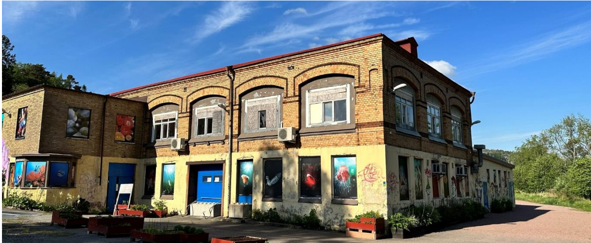
Figur 20. Kvarterets sydvästra bebyggelse. Äldre och yngre byggnadsvolymer uppförda med en viss sammanhållen arkitektur vad gäller material och färg.
