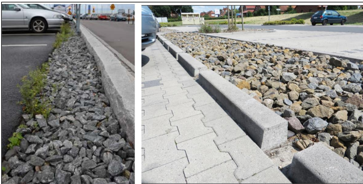
Figur 27. Till vänster: Krossdike på parkeringsyta. Bildkälla: Stockholm Vatten dagvattenstrategi, med hänvisning till Göteborgs Stads Kretslopp och vatten. Till höger: Makadamdike på parkering. Bildkälla: Svenskt Vattens Publikation (10)
