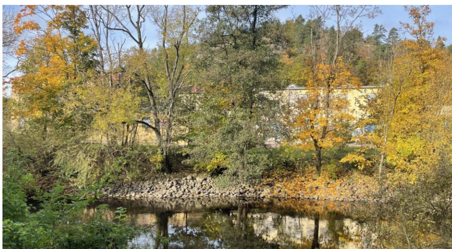
Figur 32. Anlagt erosionskydd längs med Sävåns norra kantzon mot planområdet
