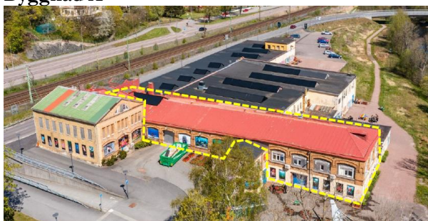
Figur 13. Byggnad A, markerad i gult, sett från väster
