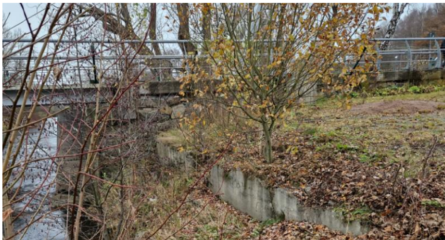
Figur 31. Betong- eller stödmurskonstruktion i anslutning till befintlig gångbro vid stationstorget
